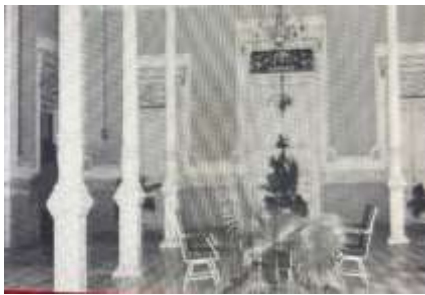
Figure IV: Soko Guru pole of Ndalem Wuryaningrat
